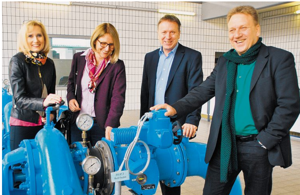
Im Wasserwerk Jägersburg in der Nähe von Einhausen informierten sich Vertreter des Kreisgesundheitsamtes. Das Bild zeigt Reinhild Zolg, Sabine Güssow, Verbandsdirektor Ingo Bettels und den Bergsträßer Gesundheitsdezernenten Matthias Schimpf (von links). FOTO: WASSERBESCHAFFUNGSVERBAND
