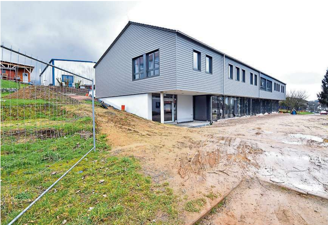
Die Arbeiten am Neubau der bhb in Fürth laufen auf Hochtouren.
